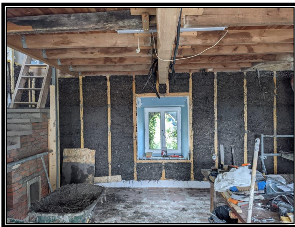
Figure 2 : Réalisation en 2022 par SOLEC d'une isolation intérieure en terre-paille lors de la rénovation d'une vieille maison en pierre. À gauche : on peut observer un tout nouvel escalier maçonné intégrant un poêle de masse type "Batch-Rocket" dont la conception interne pourrait paraître surprenante...
